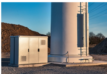
Sockel für Betonaufbau
