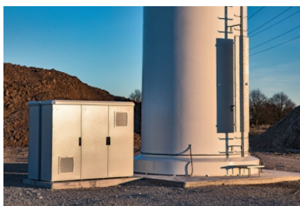
Sockel für Betonaufbau
